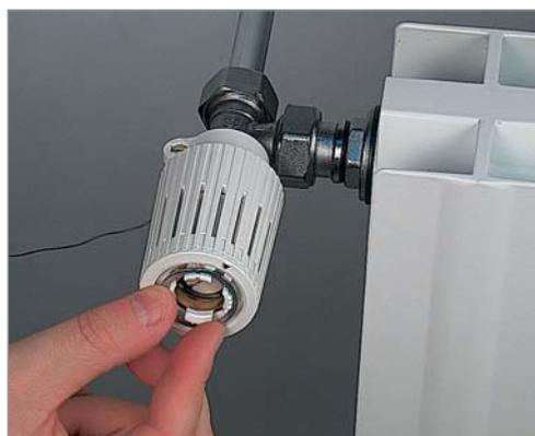
Inserire la ghiera dentata nella testa facendo in modo che il dente sporgente corrisponda alla apposita fessura presente nella parte interna della manopola. Ad operazione completata rimontare il coperchio facendo attenzione ad agganciarlo nella posizione iniziale.
