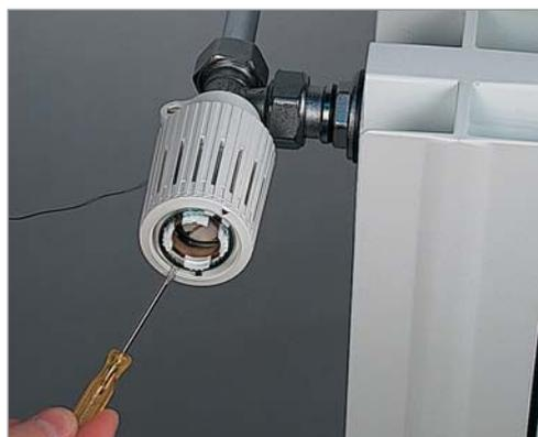
Sfilare dalla sede la ghiera dentata metallica estraendola dalla testa termostatica aiutandosi con la punta del cacciavite. Durante queste operazioni non ruotare la manopola della testa termostatica onde evitare la perdita dei punti di riferimento e quindi della posizione di taratura.
